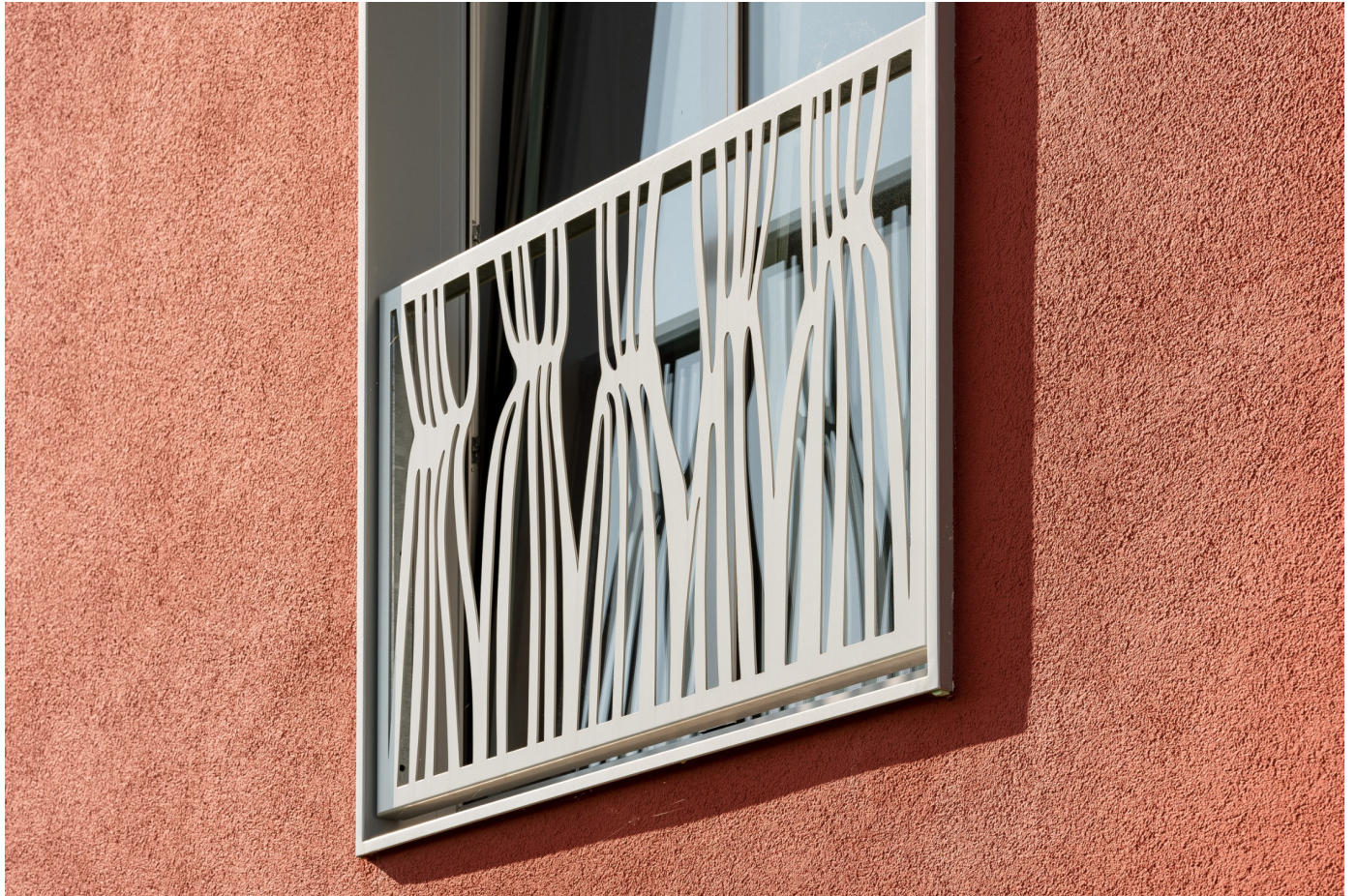
Detailblick Fassade, Fensterbrüstung von Marianne Rinderknecht
