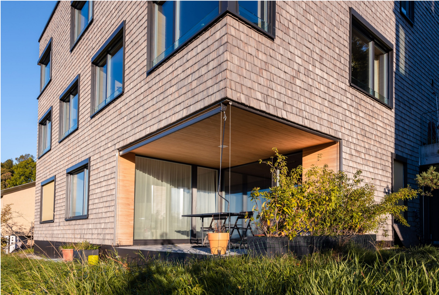
Das Schuler Blockholzsystem ermöglichte es uns durch seine "Sandwich-Konstruktion", auskragende Decken ohne Eckstütze auszubilden.
